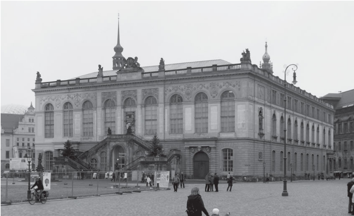
6 Dresden, Johanneum, 2008, mit (links) Probeachsen zur Fassadenauffrischung.
